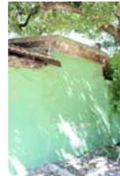
Fotoğraf 23: Baba Sultan Hamamı sıcaklık kütleli kuzey cephe
