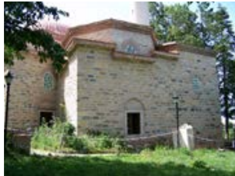
Fotoğraf 18: Baba Sultan Türbesi güneydoğudan bakışla genel görünüş
