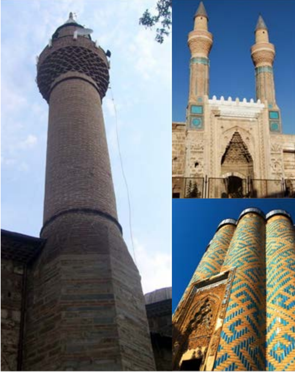
Fig. 8. İshak Paşa Camii Minaresi, Yenilenmiştir. Sivas Gök Medresenin minaresinde (Sağ üst köşede) olduğu gibi, ya da Karabağlar Türbesinde olduğu gibi (Sağ alt Köşe) bu minare de yıkılmadan önce Türk sanatının bir harikası, turkuaz renkli sırlı tuğla ile kaplı yada bir başka özgün özelliklerde olup istila ve darbelerde orijinal özelliklerini yitirmiş olabilir mi?
