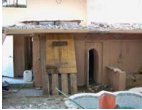
Fotoğraf 26: Baba Sultan Hamamı batıdan bakışla soyunmalık mekânı ve ılıklik kapısı
