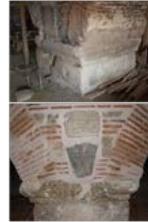
Foto 5b- Ortaköy Kervansarayı devşirme taşlardan bazıları
