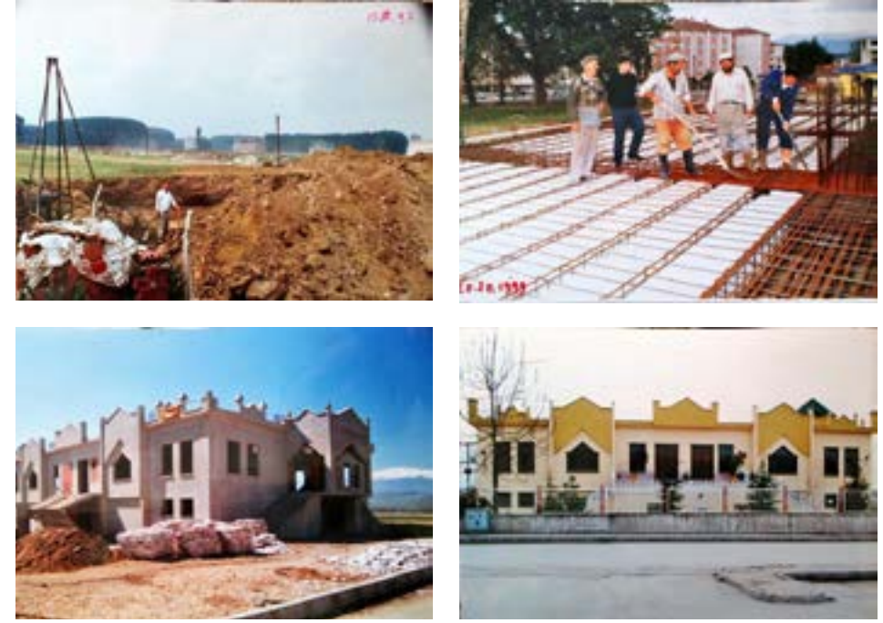
Resim 15 - Mehter binasının temel, inşaat ve nihai görüntüleri
