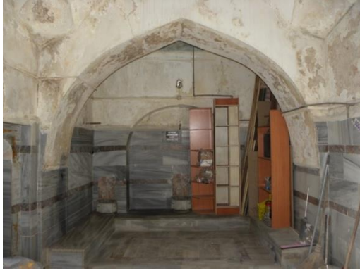
Fotoğraf 5: Yıldırım Hamamı sıcaklığının merkezinden eyvana doğru bakış.
