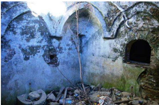
Fotoğraf 23: Akıncılar Mahallesi Hamamının sıcaklık bölümündeki tromplar.
