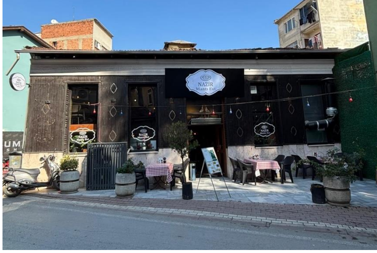
Fotoğraf 1: Yıldırım Hamamı soyunmalık bölümü batı cephesi.
