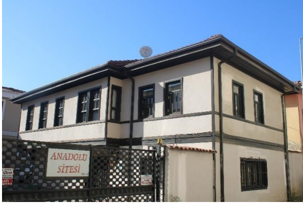
Foto. 1: Ahmetbey Sk. No: 8’deki Ev
