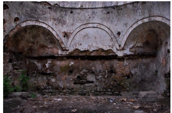
Fotoğraf 24: Yenice Hamamının sıcaklık bölümündeki tromplar.
