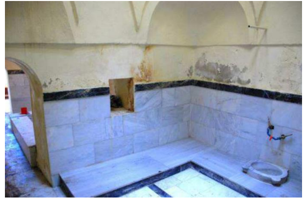
Fotoğraf 22: İnegöl Deydinler Mahallesi Hamamı sıcaklığı.
