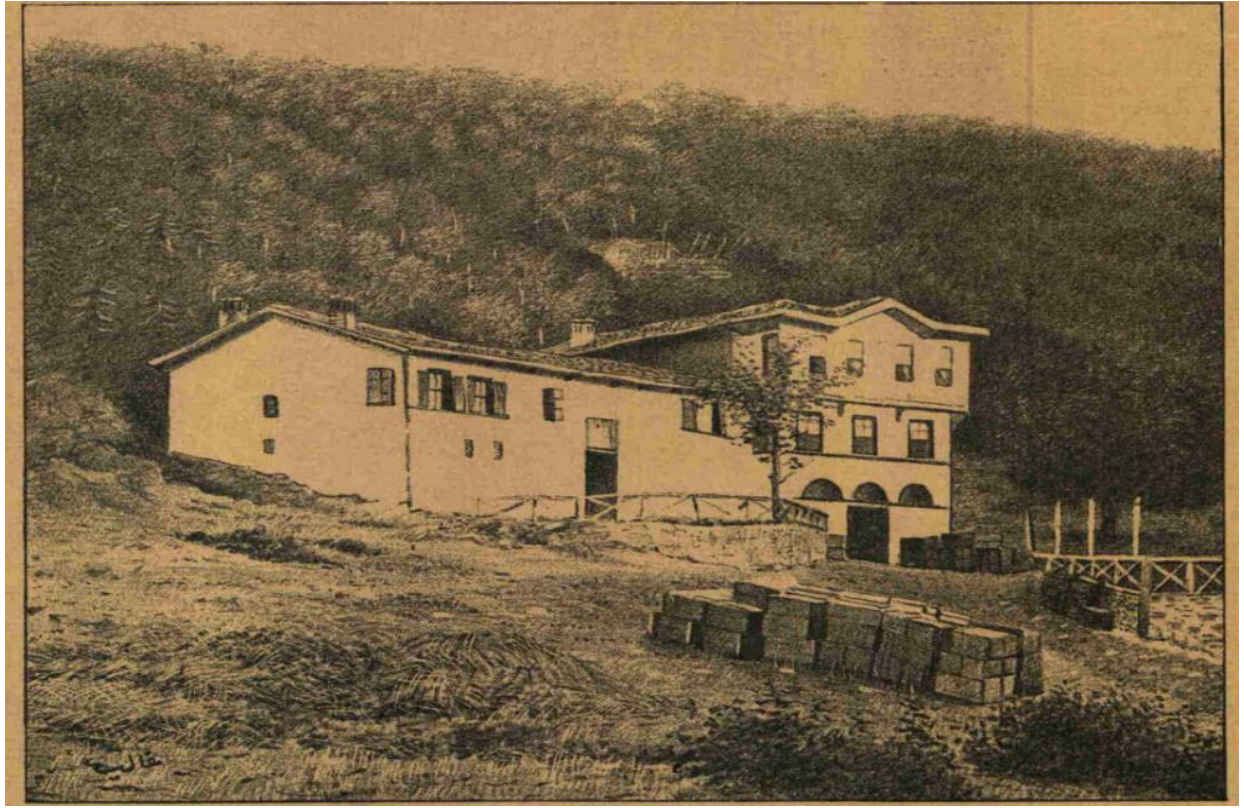
Şekil 1. Çitli Maden Suyu İşletme Binası (Servet-i Fünun, 1892)
